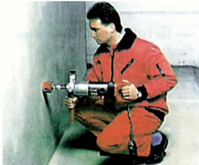
Σχ. 1-2.4γ. Διαδικασία διάνοιξης τρύπας με ηλεκτρικό εργαλείο.
