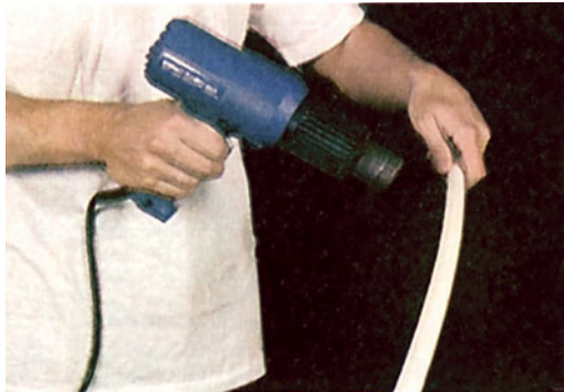
Σχ. 4-1.4ζ. Θέρμανση πλαστικού σωλήνα με αερόθερμο για να γίνει η κάμψη.
